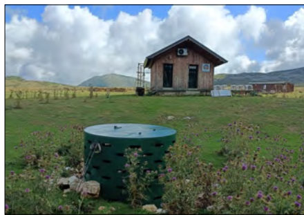
Foto 5. Struttura di ferro con funzione di filtro a protezione dell'inghiottitoio di Campocatino (Stefano Gambari, 23 agosto 2026)
