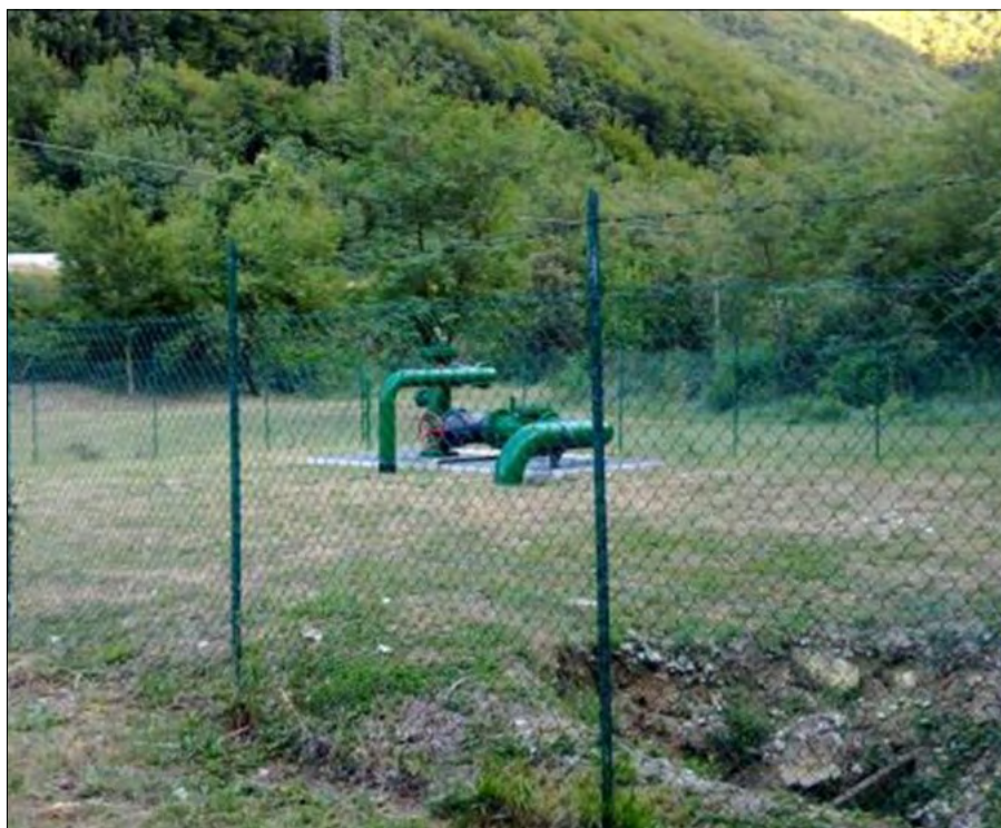
Figura 7. Il Pozzo Burano recintato
