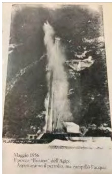
Figura 2. Acqua a pressione durante la perforazione (maggio-1956)
