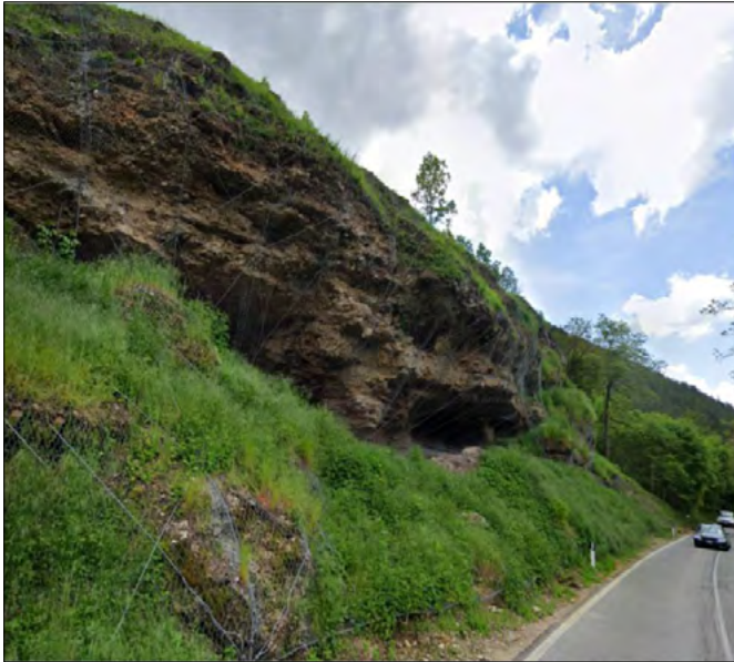
FIGURA 6. Intervento di consolidamento di un versante lungo la Strada Statale 17 bis, in prossimità del centro abitato di Assergi.
