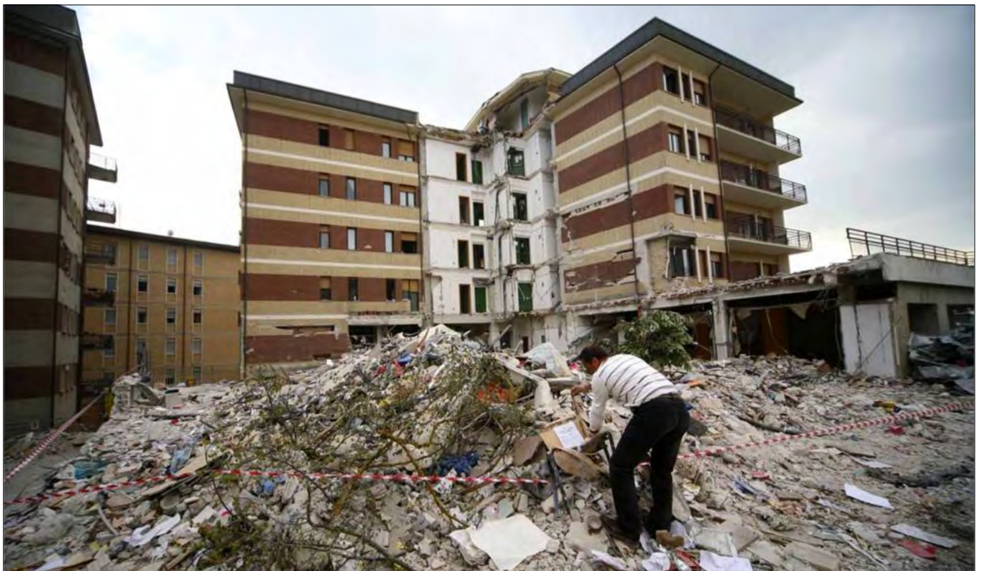
FIGURA 1. L'Aquila, la Casa dello studente crollata il 6 aprile 2009.
