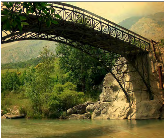
FIGURA 3. Il ponte di ferro di Lama dei Peligni (CH).
