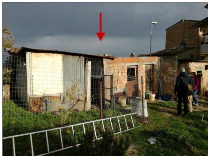
FIGURA 3. Particolari della frana di Borrano; a sinistra la situazione della zona a valle connessa a scivolamenti e colate superficiali, a destra l'abbassamento di alcuni manufatti nella zona a monte in corrispondenza di una trincea sintomo della presenza di una Deformazione Gravitativa Profonda.
