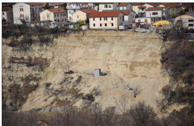
FIGURA 4. Particolare del fronte di distacco della frana caratterizzata da un crollo detritico; si intravedono alcune zone umide lungo la parete. I fabbricati a monte sono stati successivamente demoliti.
