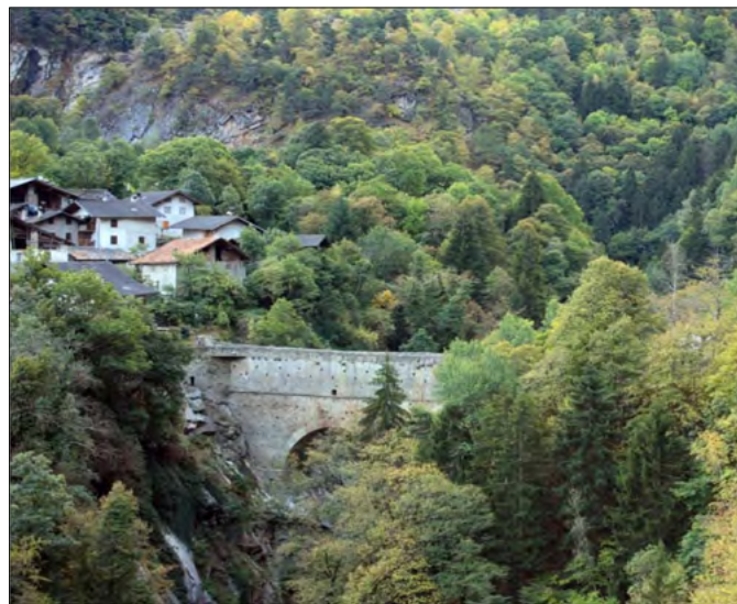
Figura 5. Pont d'Aël, col suo ponte-acquedotto romano del 3 a.C.
