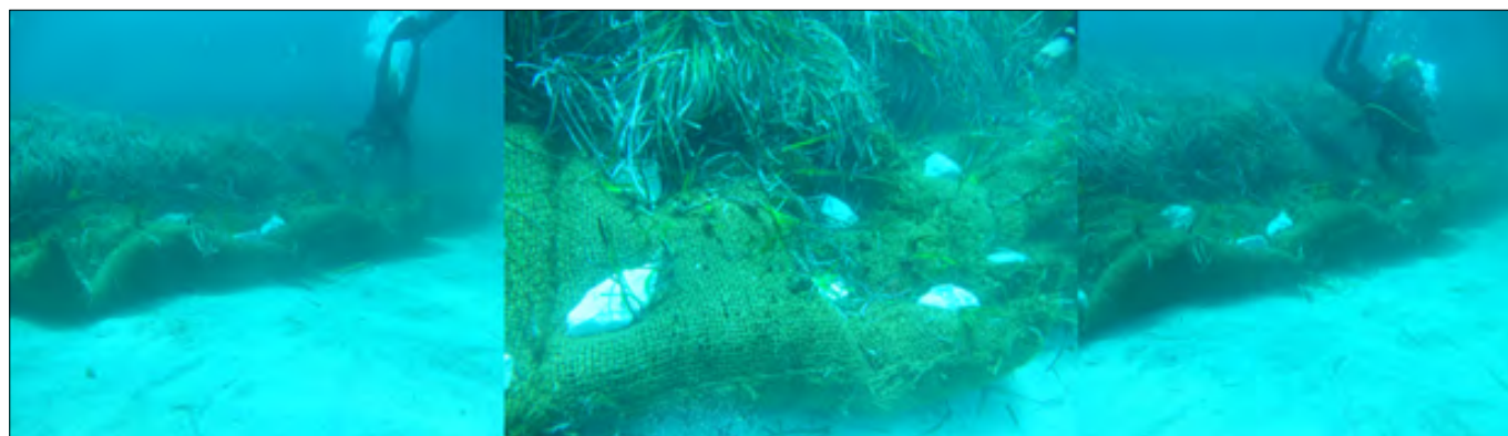
Figura 8. Primo esempi di immersione in mare di BVS utilizzando il brevetto ENEA (imbottiti costituiti da fibre naturali biocompatibili). Alcuni dettagli operativi inerenti alla stabilizzazione del substrato di BMS sul fondo marino non sono riportati e descritti in quanto ancora oggetto di implementazione
