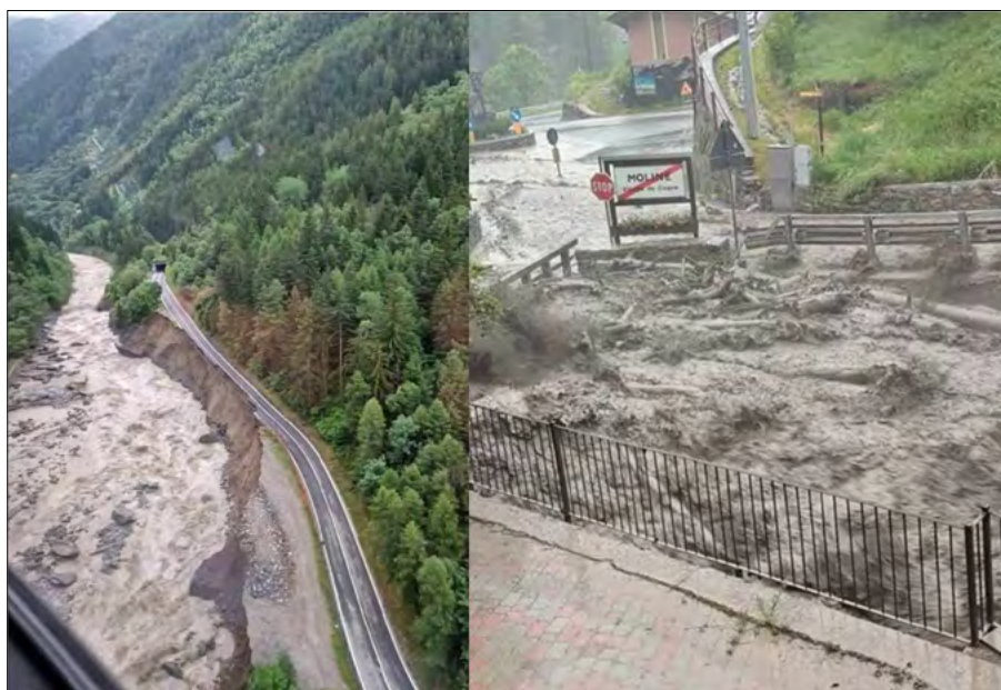
Figura 9. Evento alluvionale del 29 giugno 2024. A sinistra: una delle interruzioni della strada regionale 47, causata dalla forza erosiva del T. Grand Eyvia; a destra il T. Grauson esonda in corrispondenza della sezione 2
