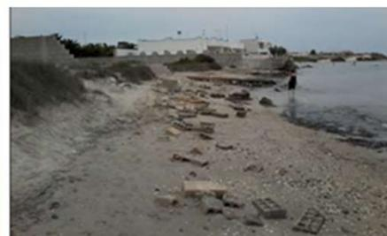
FIGURA 6. Abitazioni ormai in mare soggette a crolli e stato di intenso degrado. Si noti la presenza di un degradato cordone dunale discontinuo e smembrato per la presenza delle abitazioni.
