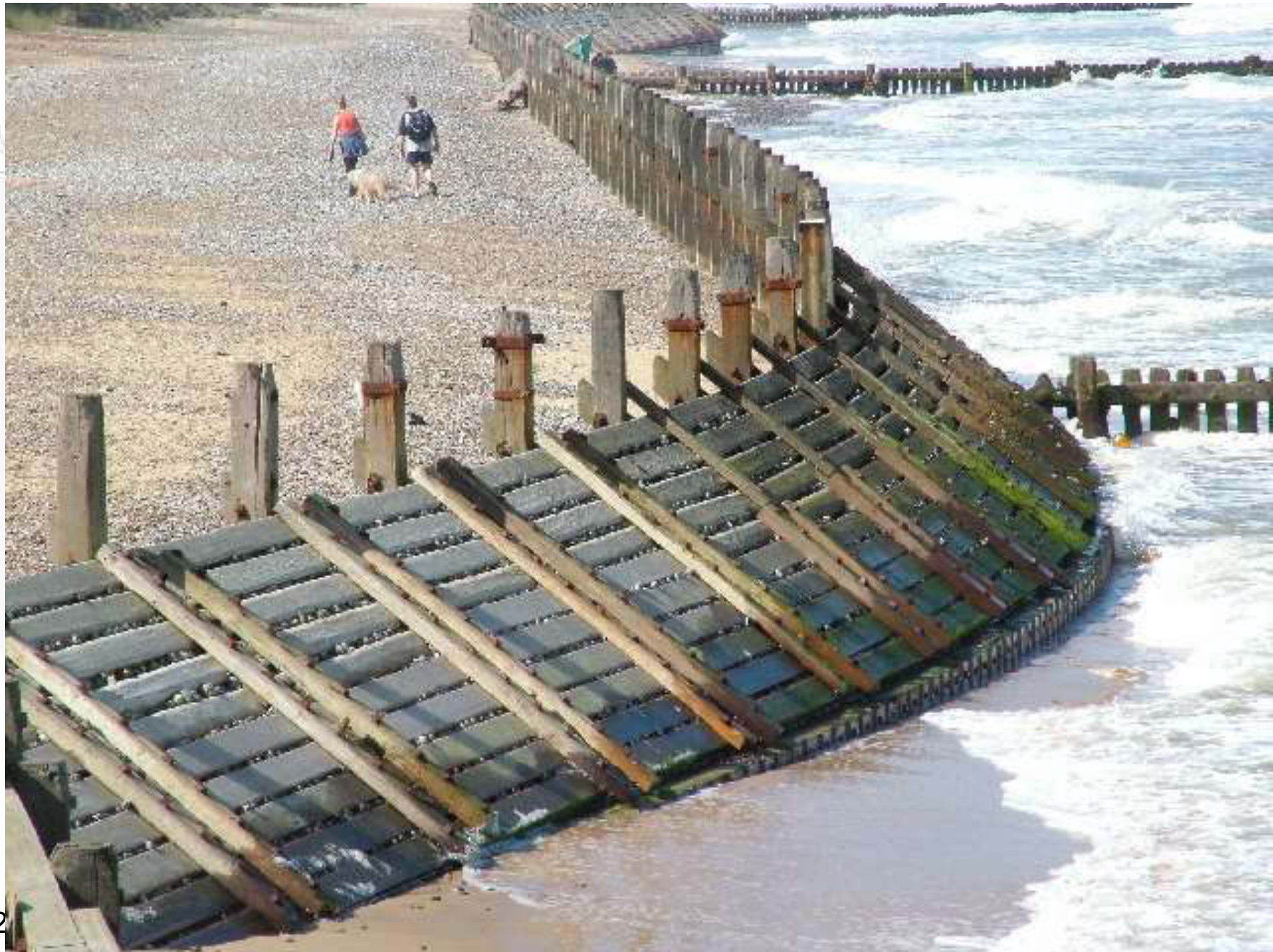
Figura - palizzate inclinate a Overstrand (UK) (da DEFRA, 1999)
