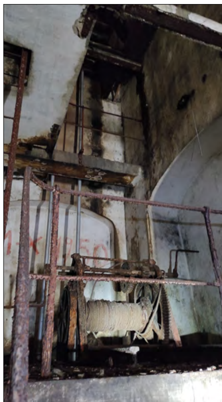
Figura 1. Il pozzo della Ferrovia scavato nella seconda metà del 1800. In a), la carrucola per il sollevamento dell'acqua; in b), la sezione rettangolare del pozzo scavato a mano nelle unità mioceniche all'interno delle quali sono presenti più livelli acquiferi
