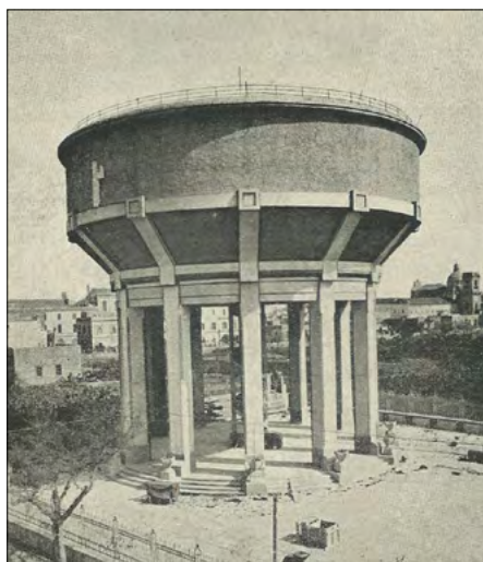
Figura 2. Il serbatoio pensile di Lecce, con la sua capacità di 4000 mc, era, all'epoca, il più grande d'Europa (quelli noti non superavano i 1000 mc) e per questo motivo, essendo una costruzione senza precedenti, vennero applicati criteri di massima prudenza. Il serbatoio venne progettato dal celebre Prof. Ing. Edoardo Orabona. Qui una foto d'epoca (da EAAP, 1933)
