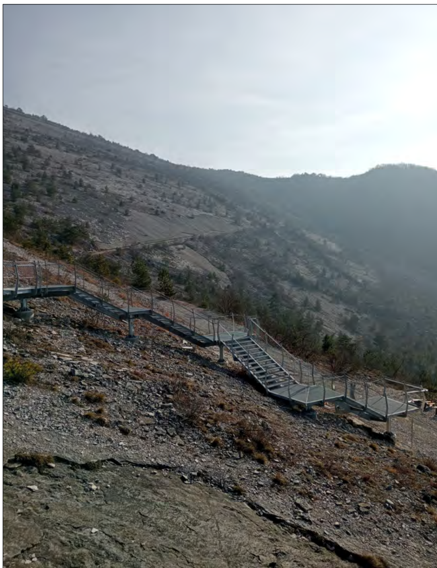
Foto 2. Fasi finali di realizzazione della nuova passerella in corrispondenza del Colatoio Chemini, una delle aree di emergenza a orme di dinosauro
