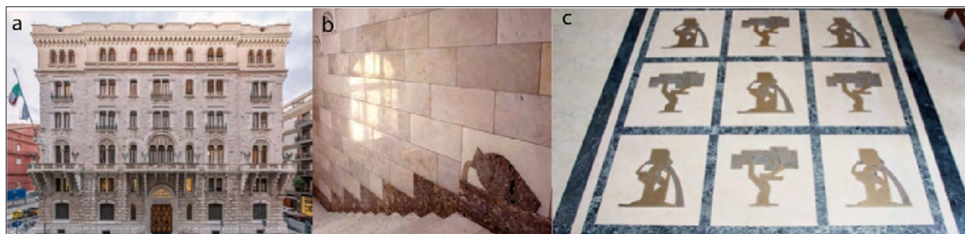
Figura 1 – Palazzo dell'Acqua: (a) facciata principale su via Cognetti, Bari (sito web AQP); (b) elementi decorativi in marmo dello scalone di rappresentanza (foto N. Amato in Mangone, 2019); (c) esempio di decorazione pavimentale, intarsio di marmi (Pietra di Trani e Verde Alpi) e figurine in bronzo (sito web AQP)
