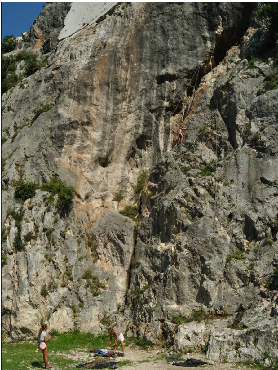
Figura 3. Tipico sito di monotiri di arrampicata sportiva, Ferentillo (Umbria) ha la base parete spianata e liberata dagli arbusti, e la parete soprastante le vie di arrampicata consolidata per evitare distacchi di detriti rocciosi
