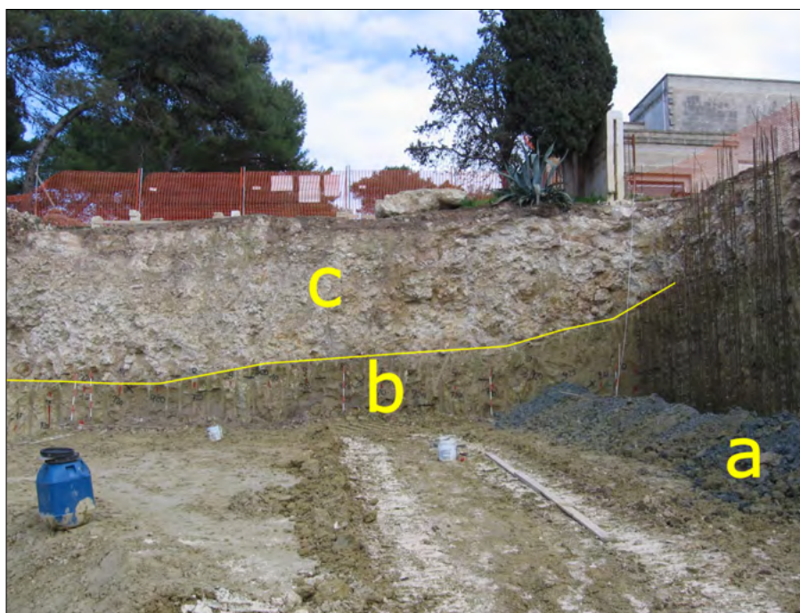
Figura 5. Località Mass. Porvica. Uno scavo ha messo in luce la locale successione stratigrafica: a) Argille Subappennine (non affioranti ma raggiunte dalla perforazione); b) Formazione di Gallipoli; c) deposito marino terrazzato
