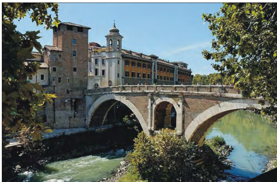
Figura 11. Ponte Fabricio, posto tra la riva sinistra del Tevere e l'Isola Tiberina. E' lungo circa 57 metri ed è costituito da due arcate, inframmezzate da una grossa pila nella quale si apre l'arco di piena.
