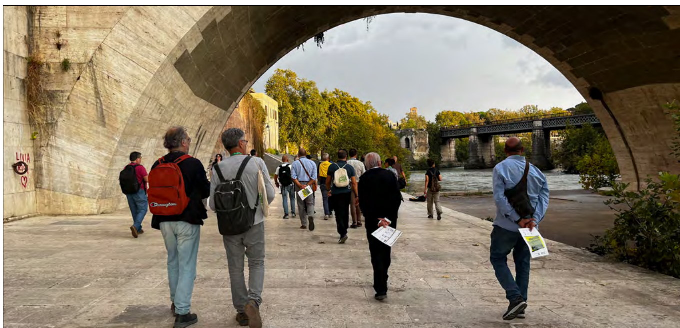
Figura 12. Escursionisti passeggiano lungo le banchine situate nella parte destra dell'isola Tiberina. E' visibile una delle tre arcate del Ponte Cestio, rivestita in travertino, ad esclusione dei sottarchi, il cui paramento è in peperino dei Colli Albani
