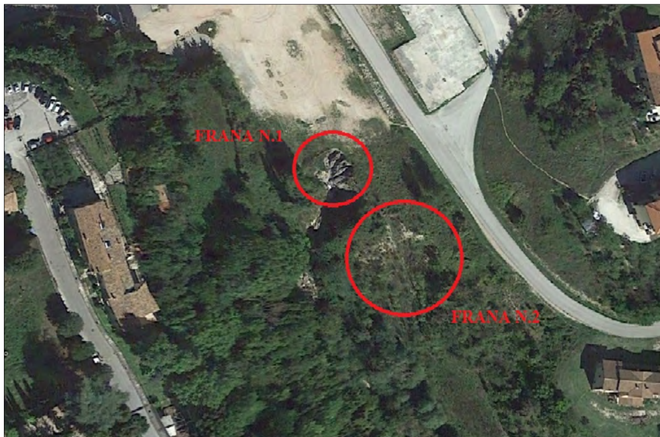
Foto 1. Individuazione area d'intervento e segnalazione delle nicchie di distacco
