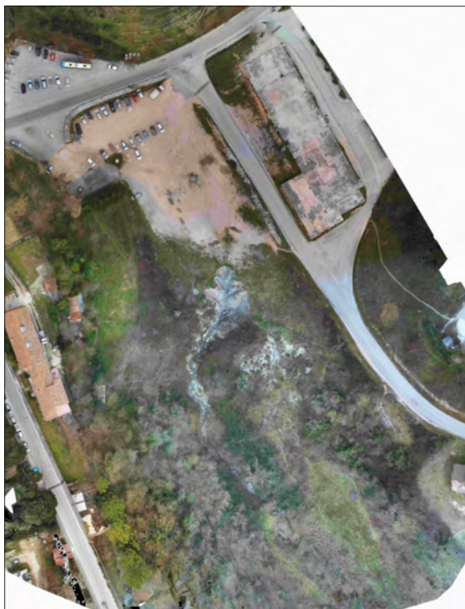
Ortomosaico (volo drone 3D) dello stato dell'area prima degli interventi di riqualificazione
