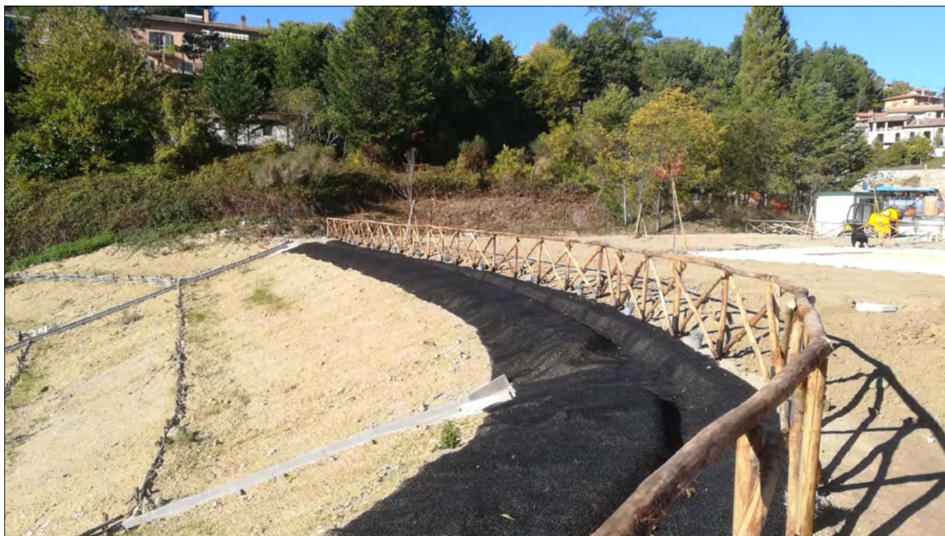
Messa in opera geostuoia sulla canaletta sommitale della scarpata e realizzazione staccionata
