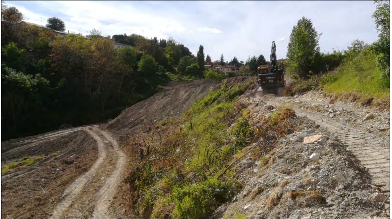
Movimenti terra e modellazione scarpate a basso angolo (da verifiche di stabilità)
