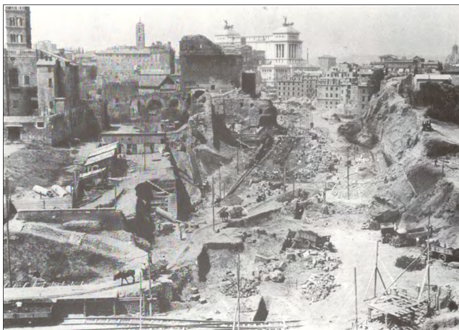
Figura 2. Collina Velia. Lavori di sbancamento, 1932
