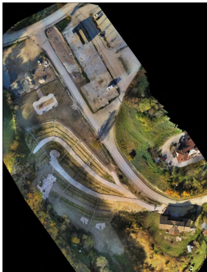
Orto-mosaico (volo drone 3D) dello stato dell'area dopo gli interventi di riqualificazione
