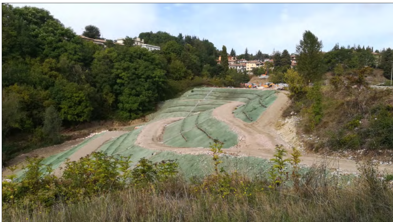
Idrosemina spinta sulle scarpate
