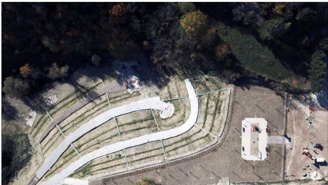
Foto area di fine lavori (ottobre 2021)
