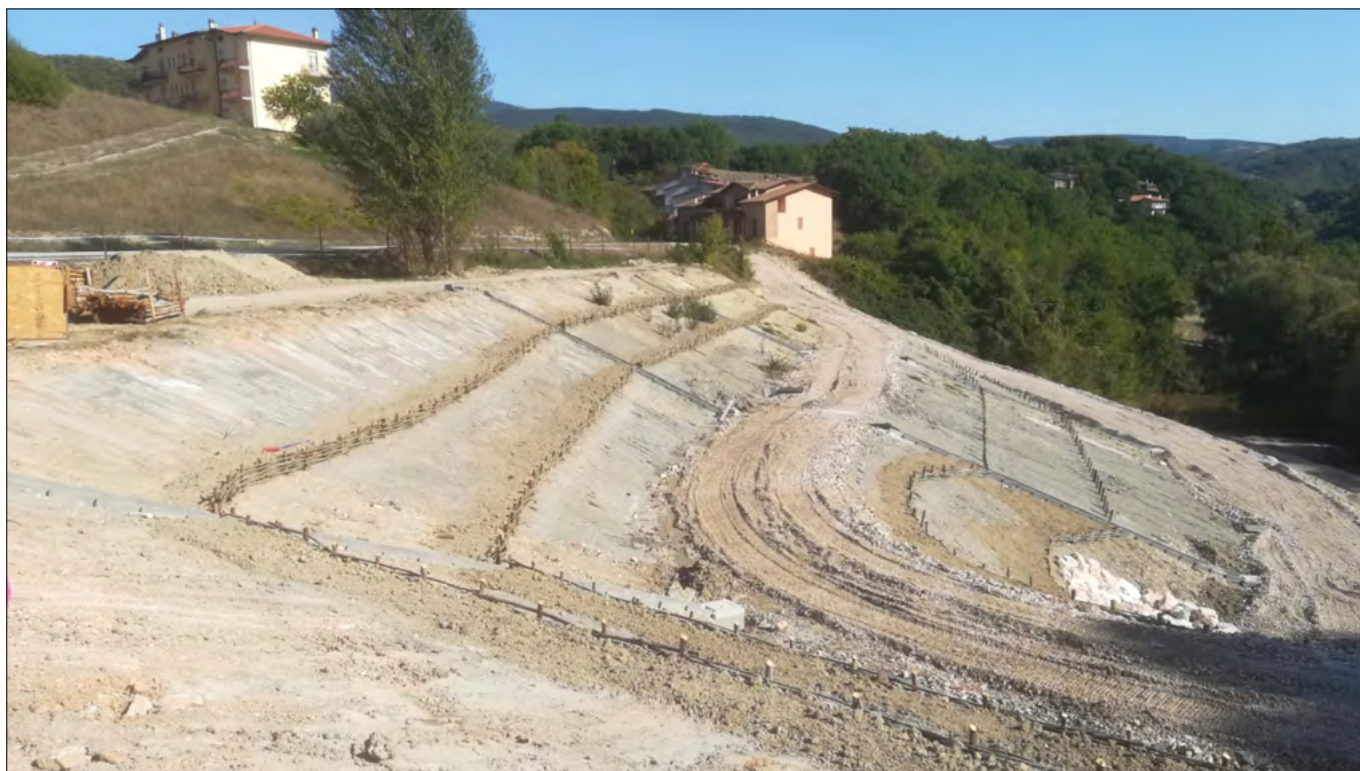
Realizzazione viminate e canalette per la regimazione delle acque piovane
