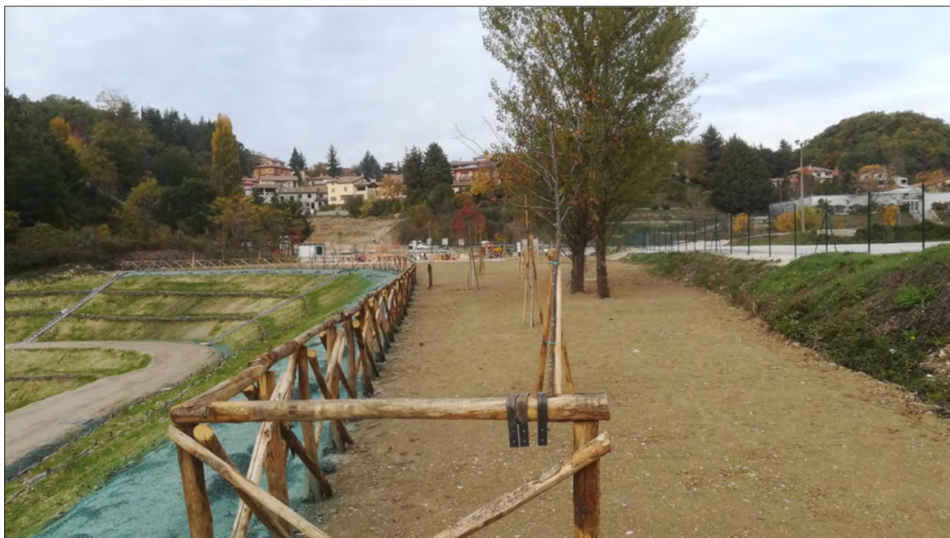
Realizzazione staccionate e piantumazione alberi del parco ambientale
