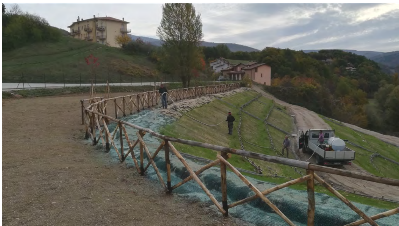
Idrosemina sulla geostuoia della canaletta sommitale
