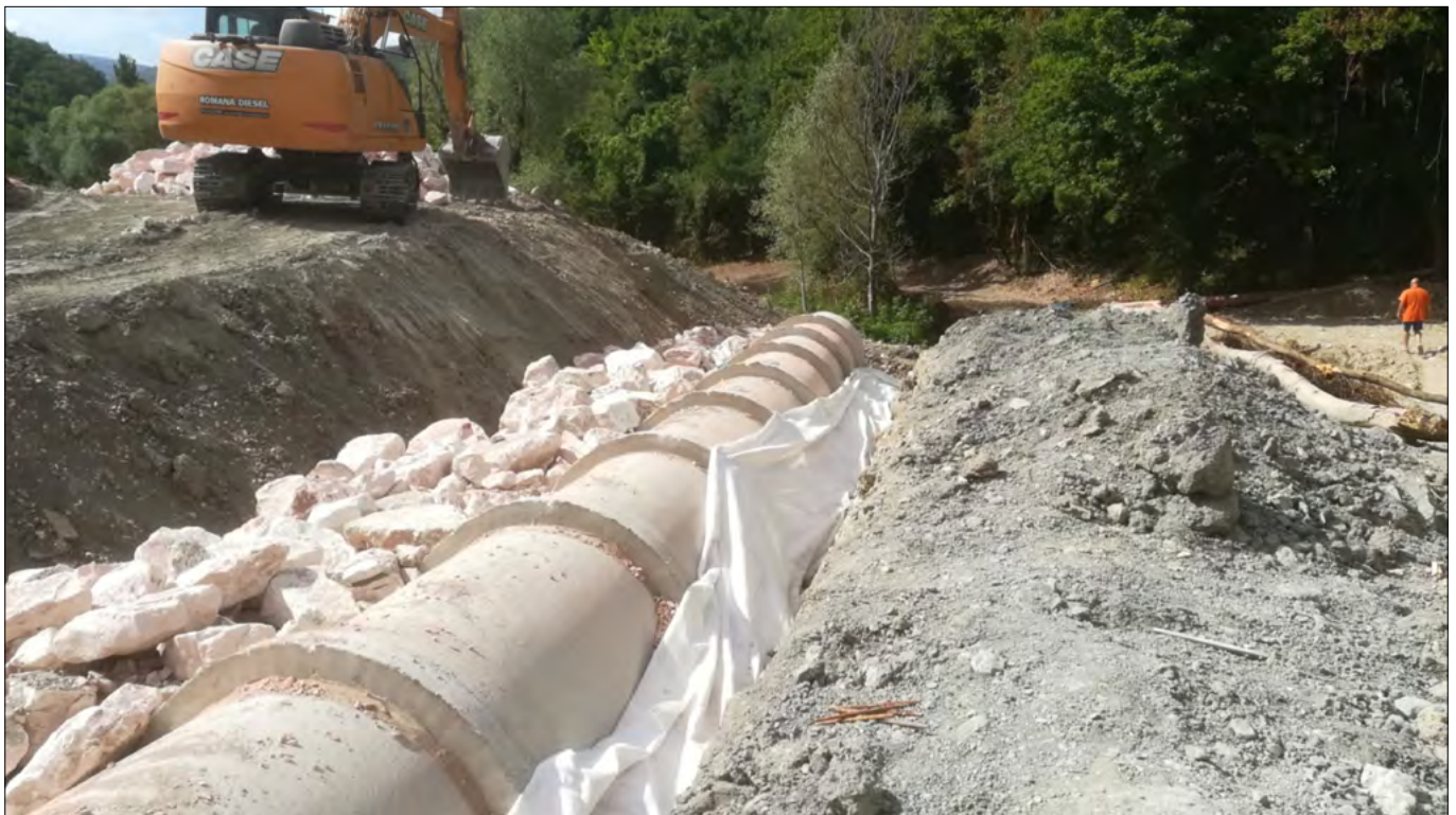
Realizzazione drenaggi e condotte drenati
