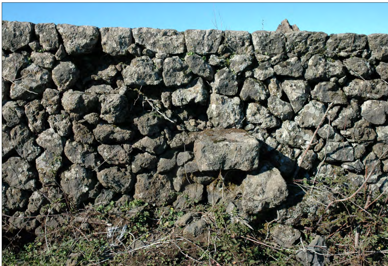
Figura 8. Muretto a secco, costruito con elementi di pietra lavica, caratteristico del paesaggio agrario etneo
