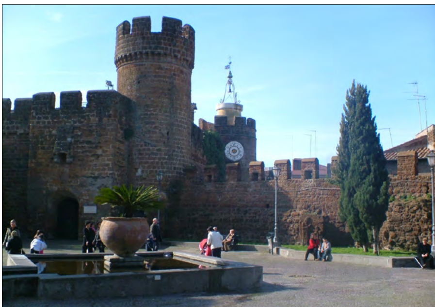
Figura 8. Cerveteri (RM), Piazza Santa Maria, in primo piano il Castello Ruspoli, con la Rocca duecentesca, merlata, munita di torri e di baluardi, ospita il museo archeologico Cerite. L'edificio, nel quale sono incorporati tratti di mura Etrusche risalenti al quarto secolo a.C., poggia la sua fondazione ed è stato costruito utilizzando la formazione geologica del "Tufo Rosso a scorie nere"
