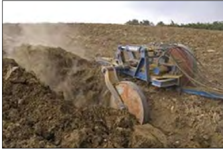
Figura 8. Intervento di scasso "sostenibile" mediante trincee
