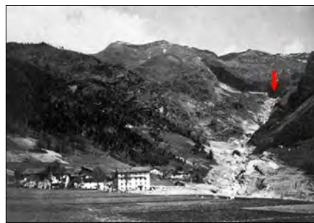
Figura 4. Abitato di Bueggio, il primo ad essere colpito dall'ondata. I segni del passaggio della valanga d'acqua sono ben visibili sui versanti. In alto, con la freccia, è indicato il varco della diga ( www.scalve.it , modificata)
