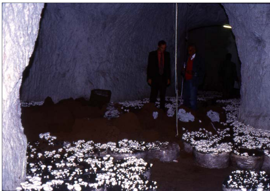
Figura 10 – Le ex cave di pozzolana vengono utilizzate a Roma per la coltivazione dei funghi, a causa dell'ambiente idoneo. Le "fungaie" costituiscono quindi una risorsa per la città, ma anche un rischio, poiché l'improvviso crollo della volta delle gallerie può comportare il ferimento o la morte degli operai addetti (Foto G. Gisotti).
