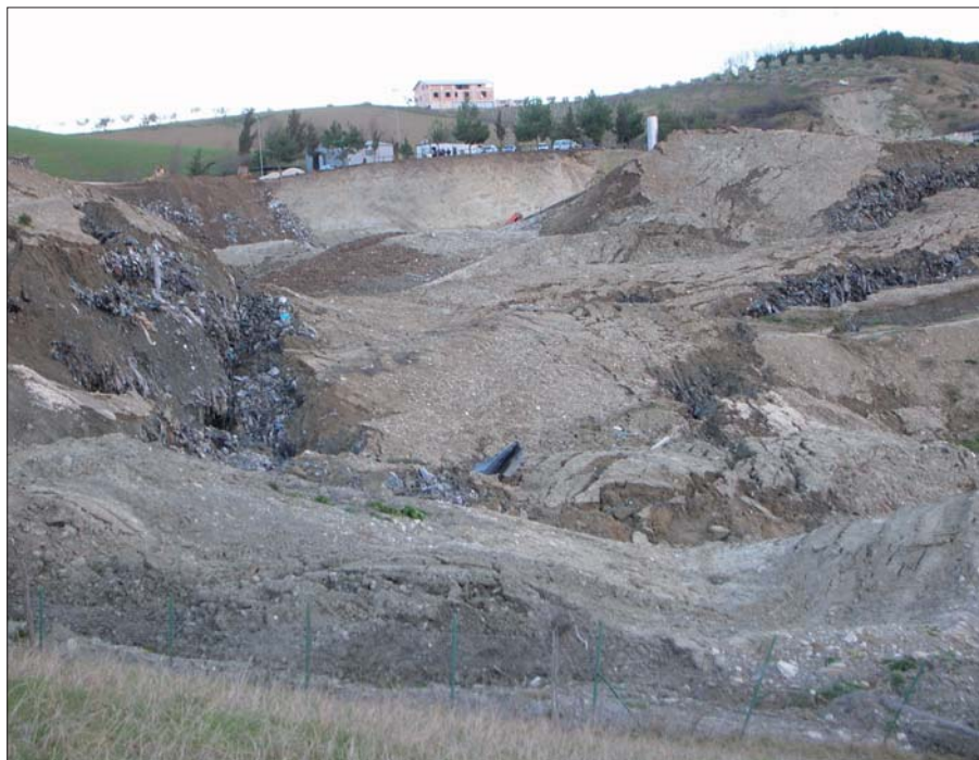
Figura 22 – Immagine scattata il 17.02.2006, il giorno stesso del franamento. In alto la nicchia di distacco della frana, dove affiora il substrato geologico della discarica. La massa dei rifiuti misti alla terra che formava gli strati di copertura si mostra fortemente dislocata e modellata con numerose contropendenze.
