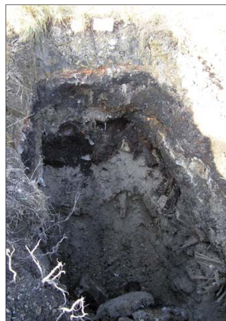
Figura 8 – Terrapieno di Barcola, Bovedo. Una buca eseguita tramite escavatore, profonda 4-5 m. La stratigrafia mostra la presenza di uno spesso strato di scorie nere da inceneritore, intercalato fra terre e rocce da scavo e rifiuti da demolizione (Foto G. Gisotti).
