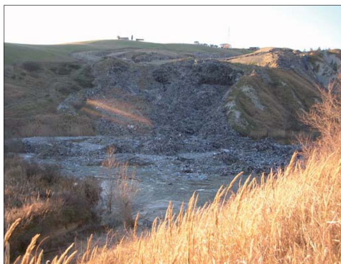
Figura 24 – Nella parte inferiore del versante collassato si nota il restringimento del bacino calanchivo sagomato per ospitare i rifiuti: a destra è visibile una prominente del substrato argilloso che costituisce un argine naturale della discarica. Al centro si nota come i rifiuti abbiano sormontato l'argine di contenimento artificiale realizzato ai piedi della discarica.
