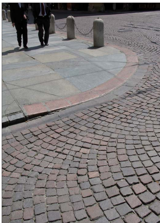
Figura 3 – Angolo tra via Emilia e piazza Matteotti. In alto a sinistra marciapiede in lastre di beola grigia e ghiandonata bordato da cordolo in porfido rosso di Cuasso che passa all'estrema sinistra in granito bianco di Montorfano. A destra e in alto cubetti in porfido atesino. I fittoni sono in rosso ammonitico.
