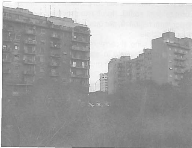
Situazioni problematiche: Roma, Zona S. Paolo
