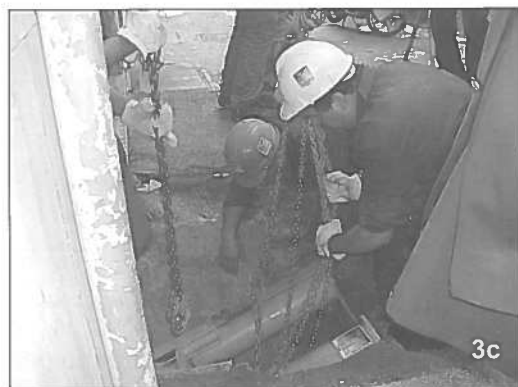
Figure 3a, 3b, 3c - Una delle caratteristiche è l'estrema compattezza e manovrabilità dell'attrezzatura d'infissione del palo Soles®. Nelle immagini sono riportate alcune fasi di consolidamento delle fondazioni di un condominio di 50 appartamenti mediante l'utilizzo dei pali Soles® nel centro storico di Roma operando solo dal piano interrato.
