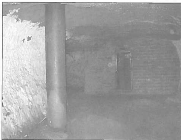
Figura 4 - Roma, Un palo di grande diametro "incamiciato" per il superamento di una cavità.
