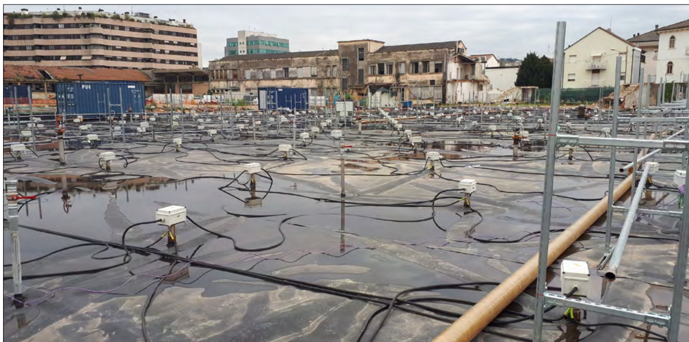
Figura 4. Trattamento termico in situ per la rimozione di composti volatili dal sottosuolo (centro storico di Vicenza, ex area Zambon)
