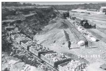
Figura 16 – La realizzazione della grande infrastruttura portuale richiese un altrettanto grande impegno organizzativo del cantiere. Le cave da cui furono prelevate le enormi quantità di roccia erano situate a Palese e fu adattata l'esistente ferrovia per il trasporto su rotaia del materiale cavato. L'ampia area di cava a Palese. (da Trizio P., 2003).
