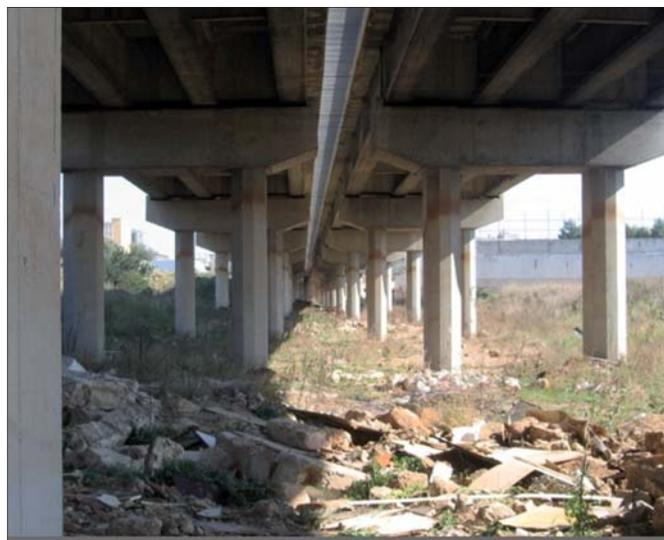
Figura 8b – Tracce della corrente sui piloni del ponte.
