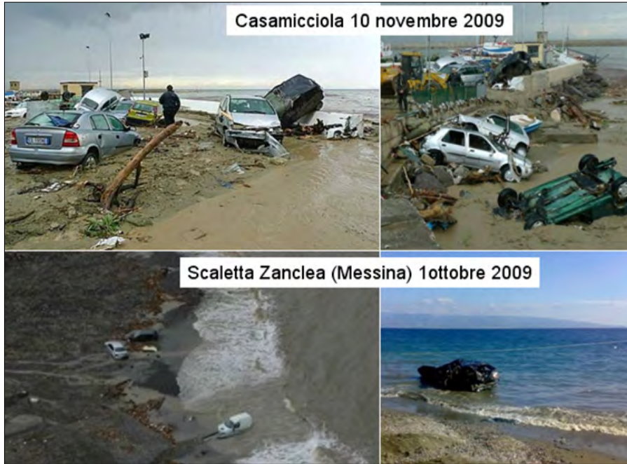
Figura 16. In alto, fango, detriti, alberi e auto accatastati sul piazzale del porto e sulla sottostante spiaggia nella zona di conoide costruita dai flussi fangosi del 10 novembre 2009. In basso, scenario analogo nella zona della foce del Torrente Racinazzo di Scaletta Zanclea (Messina) dove il 1° ottobre 2009 si è riversata una potente colata detritico-fangosa la cui portata è stata stimata di varie centinaia di mc/sec (Ortolani e Spizuoco, ottobre 2009)
