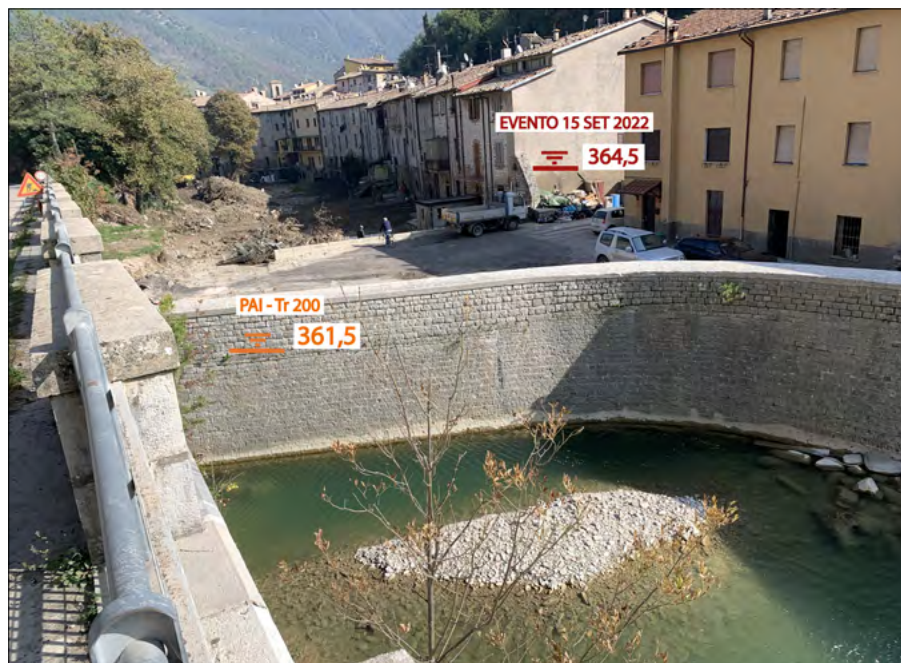
Figura 9. Limiti degli strumenti di prevenzione e gestione dell'emergenza: confronto tra il livello di piena previsto dalla perimetrazione PAI basata sul Tr200 (361,5m s.l.m. stimato) e l'effettivo livello idrometrico raggiunto dall'ondata di piena durante l'evento alluvionale del 15/09/22 (Tr=1.000 anni? 364,5m stimato), nel tratto del F. Burano (Cantiano) prima di entrare in galleria con un "taglio di meandro", come già evidenziato in Fig. 7a/b
