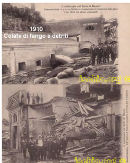
Figura 5. Esempi della devastazione causata dalle colate rapide di fango e detriti dell'ottobre 1910
