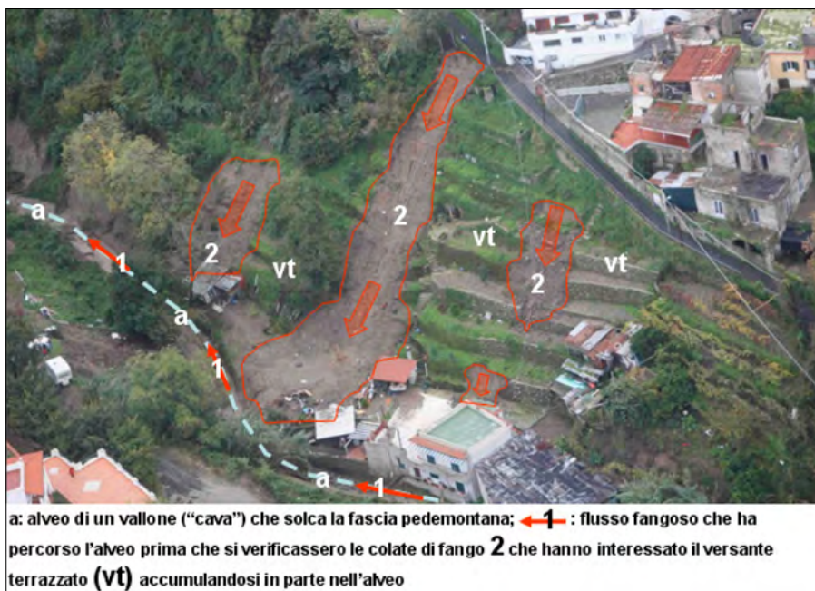
Figura 9. Esempi di dissesti che hanno interessato i versanti terrazzati. Le colate di fango si sono prevalentemente accumulate nell'alveo dopo il transito di flussi fangosi
